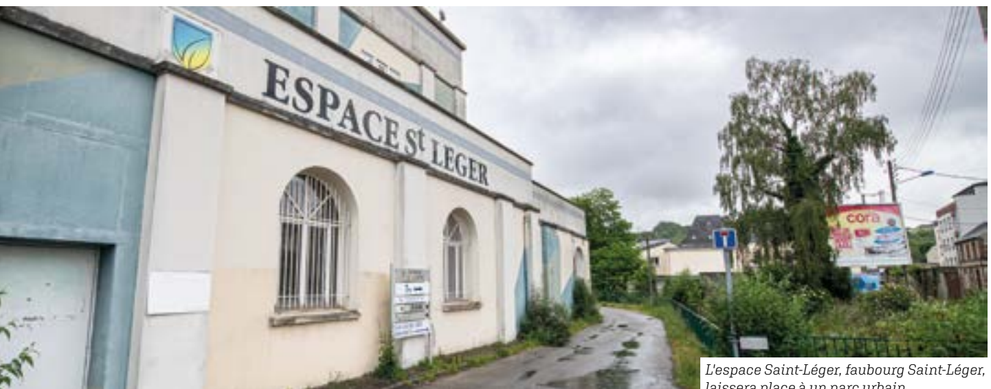
La friche industrielle Aspocomp, rue Pierre Brossolette, quartier du Clos-au-Duc.
